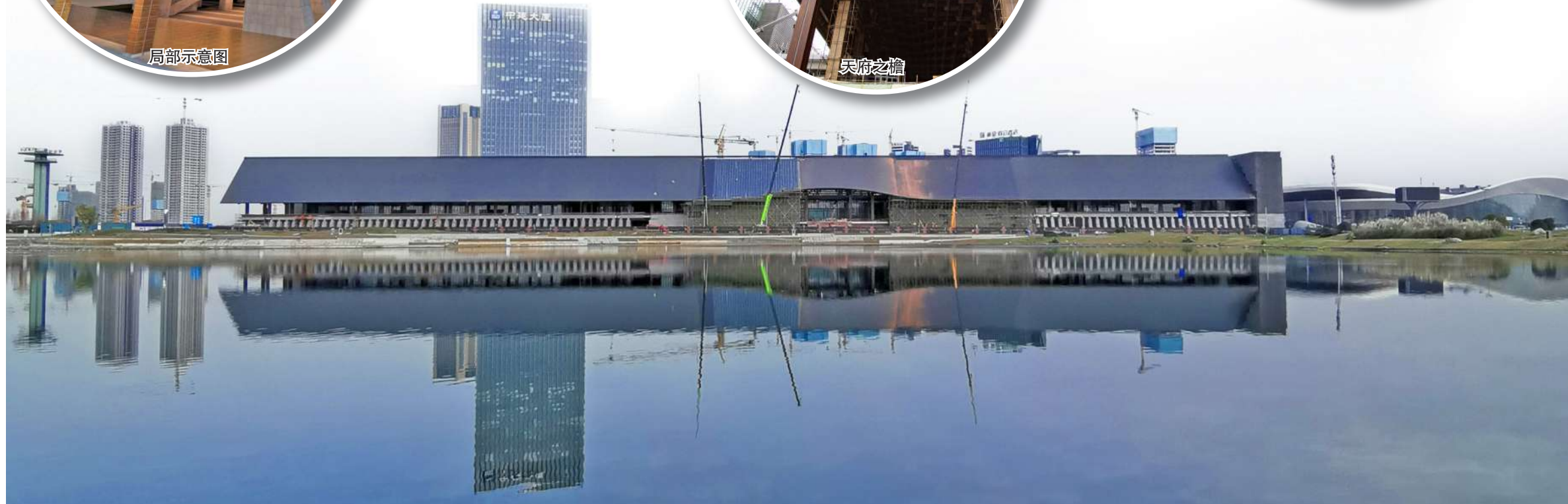
主体完工的天府国际会议中心初显魅力
